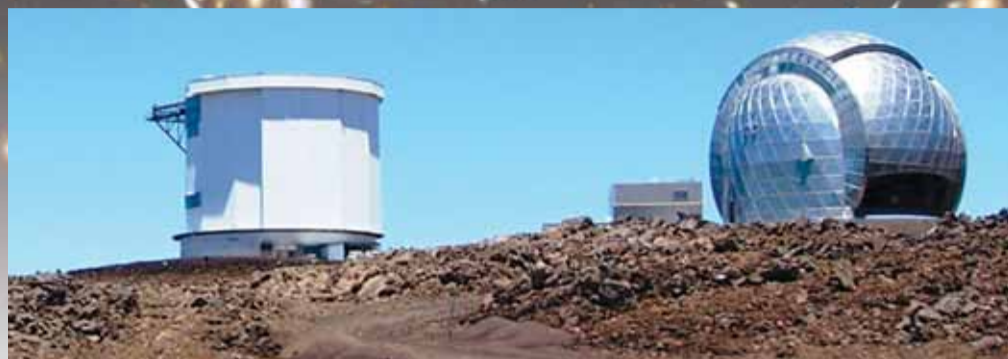
Два из четырех самых больших телескопов, расположенных на потухшем вулкане в обсерваториях Мауна Кеа на Гавайях, используются для получения изображений неба. Слева телескоп имени Джеймса Клерка Максвелла — это телескоп субмиллиметровой длиной волн диаметром 15 м. Справа телескоп «Caltech» субмиллиметровой длиной волн 10.4 м.
